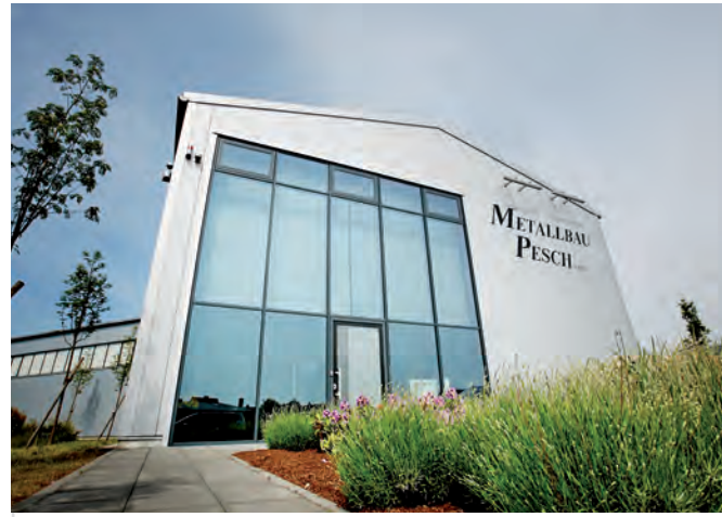
Na cidade de Hürth, próxima à cidade de Colônia, a empresa Metallbau Pesch já está estabelecida há 30 anos. Em 2010, a sede da empresa mudou-se para a rua Winterstraße.
