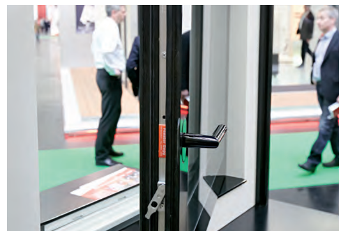
Na feira especializada em Nuremberg foi apresentada a janela completa de vidro revo® cujo caixilho é completamente coberto com vidro no lado externo e interno. “Um modelo muito moderno que entusiasma os seguidores da arquitetura purista”, relata Götz Gegg.
