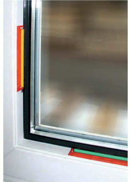
Executado por especialistas: Cantos espaçados com calços corretamente de uma janela oscilobatente com calços de envidraçado de 5 mm de espessura e 100 mm de comprimento.
