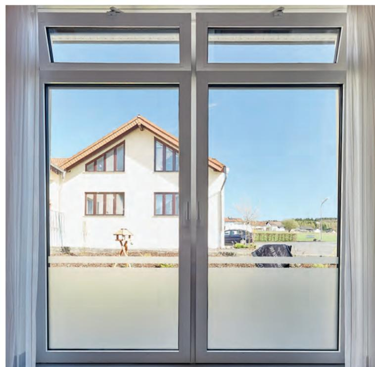
Duas portas janelas com abertura oscilobatente e duas claraboias com abertura manual permitem aos moradores da residência de idosos receber ventilação individual em seus apartamentos e o acesso sem barreiras às suas varandas e terraços.
