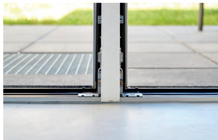
Esta solução é reconhecida como sem barreiras conforme a norma DIN 18040-2: Uma ferragem oscilobatente do sortimento Roto AL 540, combinada com componentes adicionais para atingir uma execução sem barreiras.
